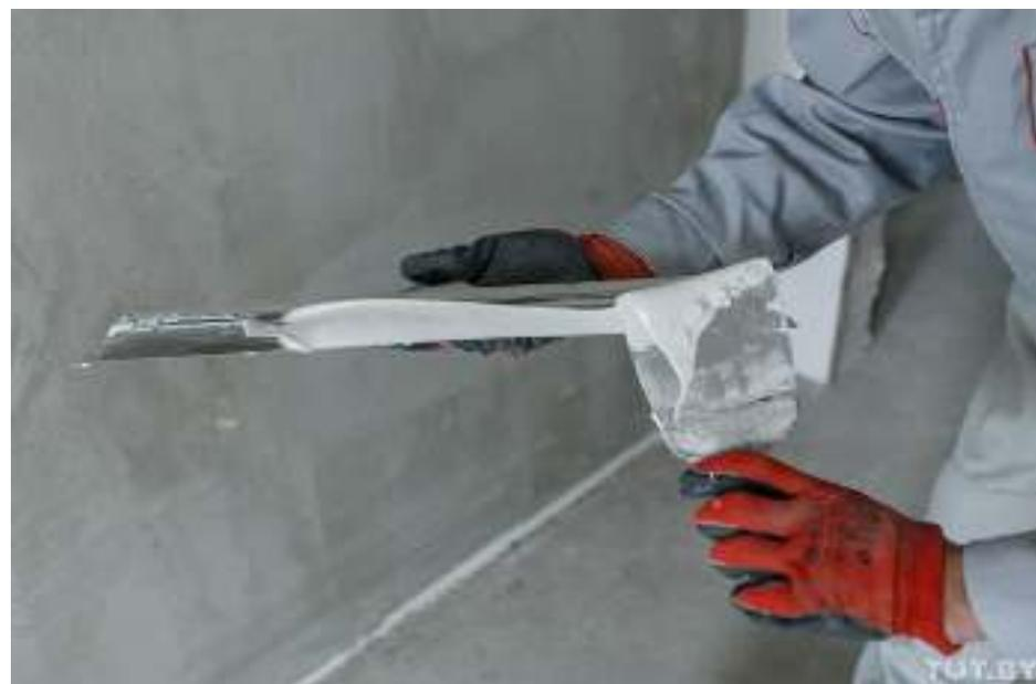
5. Прежде чем шпаклевать стену под покраску, дождитесь полного высыхания предыдущих слоев. Стартовая и первый слой финишной шпаклевки должны быть абсолютно сухими. На это приблизительно уходит около 12 часов. Затем можно наносить финишную шпаклевку.
