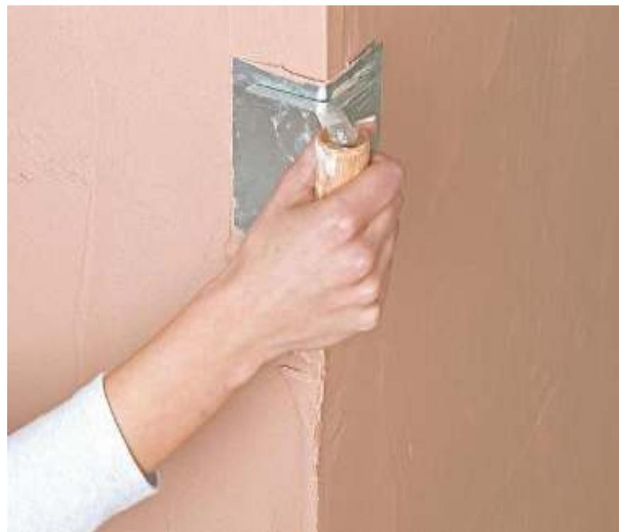
4. Как только стартовая шпаклевка полностью высохла, приступайте к выполнению финишной шпаклевки. Для работы используются большой и маленький шпатель. На большой шпатель маленьким шпателем небольшими порциями накладываем шпаклевку. Затем равномерно наносим шпаклевочную смесь на поверхность. Толщина слоя около 1,5 - 2 мм.
